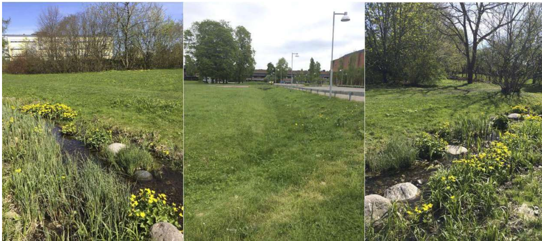
Figur 11. Exempel på dagvattenlösningar i form av öppna diken och svackdiken. Foto Erika Hagström, Structor.
